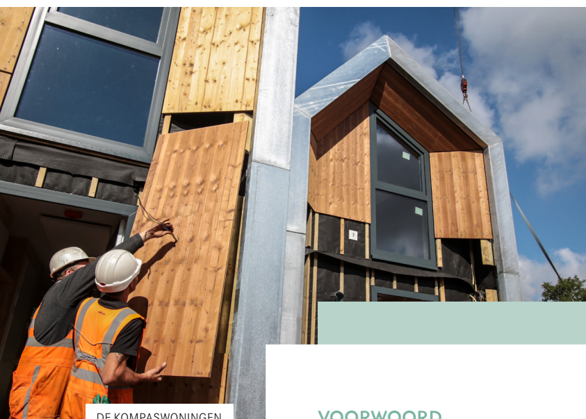
DE KOMPASWONINGEN IN AANBOUW
